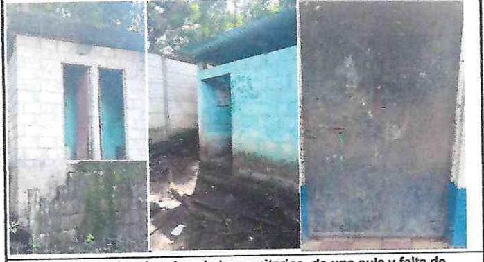
Foto 2: puertas deterioradas, de los sanitarios, de una aula y falta de puerta en la cocina.
