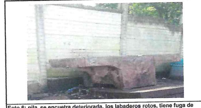
Foto 6: pila se encuentra deteriorada, los labaderos rotos, tiene fuga de agua.
