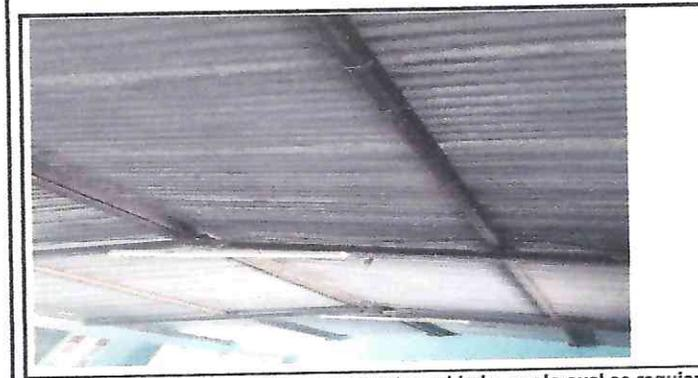
Foto 5: la estructura metalica se encuentra oxidada, por lo cual se requiere de mantenimiento de pintura.
